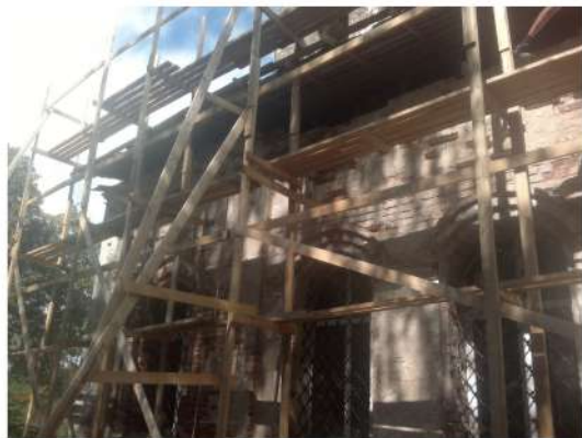
Монтаж строительных лесов
