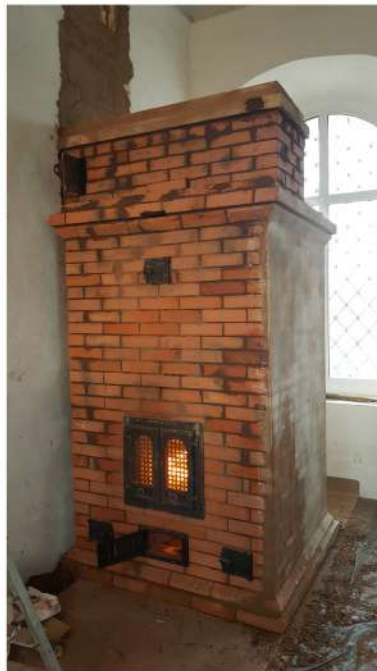
Этапы кладки кирпичной печи для отопления Храма
