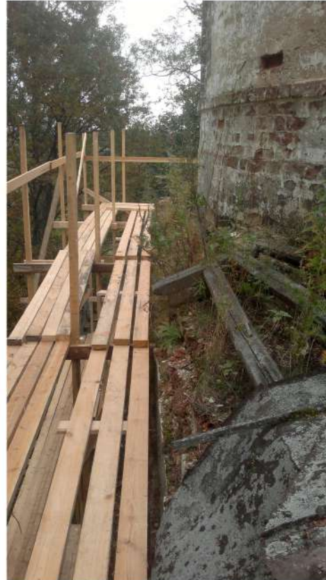
Монтаж стойтельных лесов
