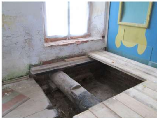
Монтаж деревянного пола с учётом сохранившегося
