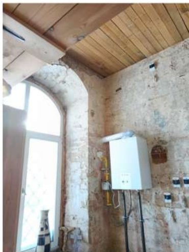
Установка газового котла
