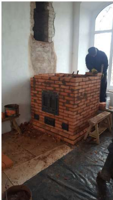
Этапы кладки кирпичной печи для отопления Храма
