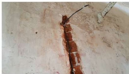
Устройство электропроводки
