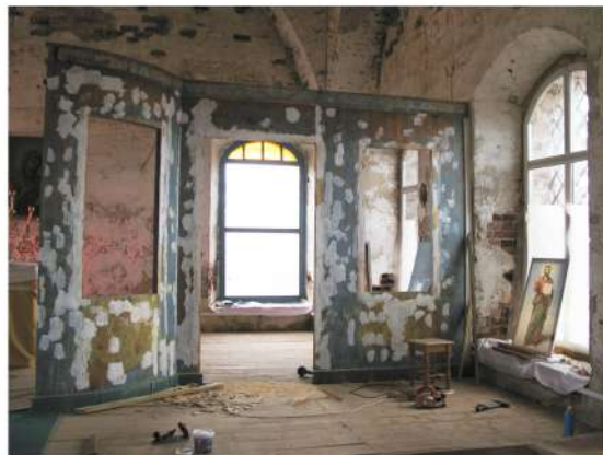
Работы по реставрации иконостаса
