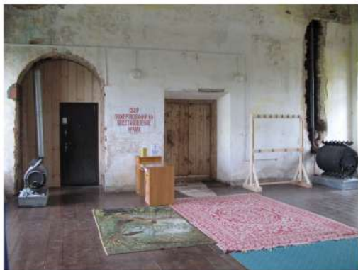
Установка двух металлических обогревательных печей
