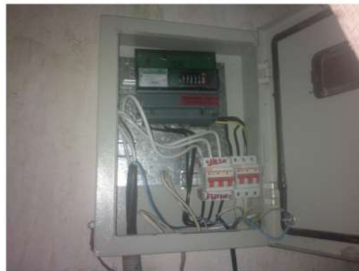
Проведение работ по прокладке электропроводки
