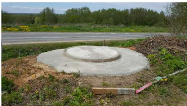
Установка фундамента под стеллу на въезд в деревню
