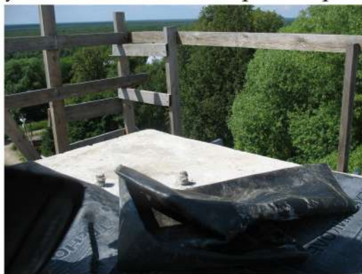
Монолитная конструкция для установки шпиль, шатровой кровли
