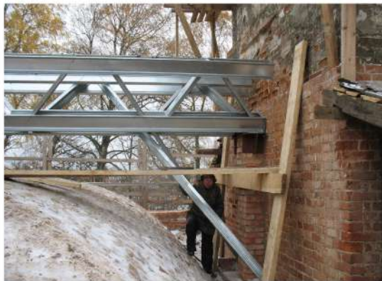
Стропильная система
