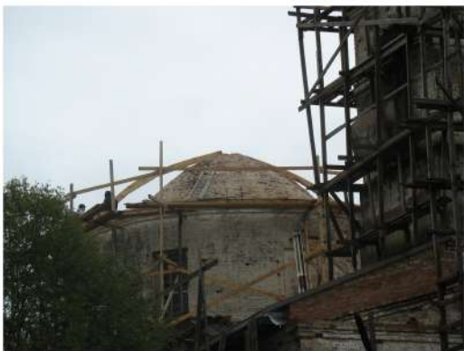
Монтаж новой кровли
