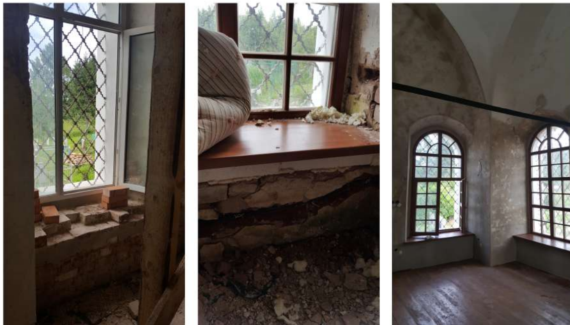
Восстановление кирпичных стен под окнами.
