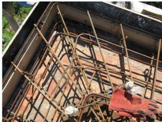
Монолитная конструкция для установки шпиль, шатровой кровли
