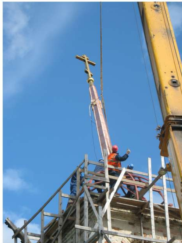
Установка шпиля и креста
