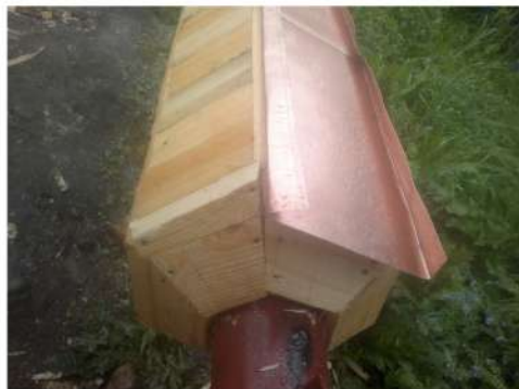
Облицовка шпиля медными листами
