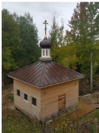
Завершение строит-ва здания купели
