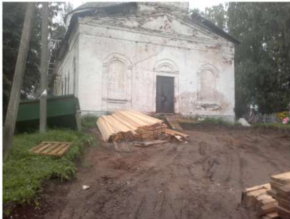
Начало работ по благоустройству
