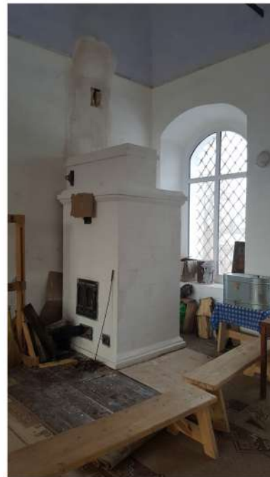
Этапы кладки кирпичной печи для отопления Храма
