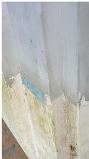
Этапы отделки (штукатурка, грунтовка, покраска) наружных стен фасадов
